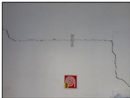
Fessurimetro 1 – misurazione del 18/09/2015
